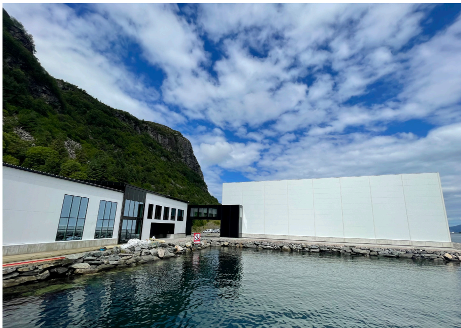
Bildet viser litt av administrasjonsbygget og den nye hallen som skal hus en 17-meters (diameter) og en 22-meters tank. Foto: Øystein Torheim, frequency.no
